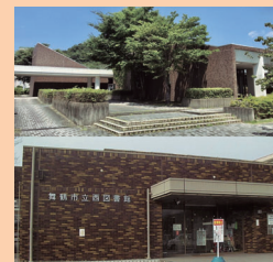
築30年以上が経過した 東西図書館
